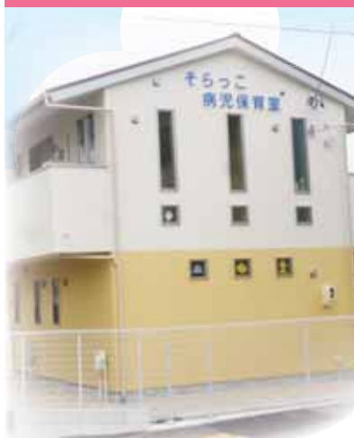
▲5月～8月まで新築工事、予定通り9月1日オープンとなった「そらっこ病児保育室(2階)」(1階は名南会院内保育・つっこ保育所)
