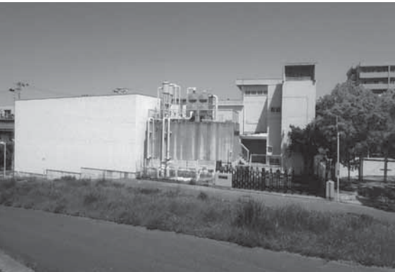
▲天白川堤防から見た弥富ポンプ所
